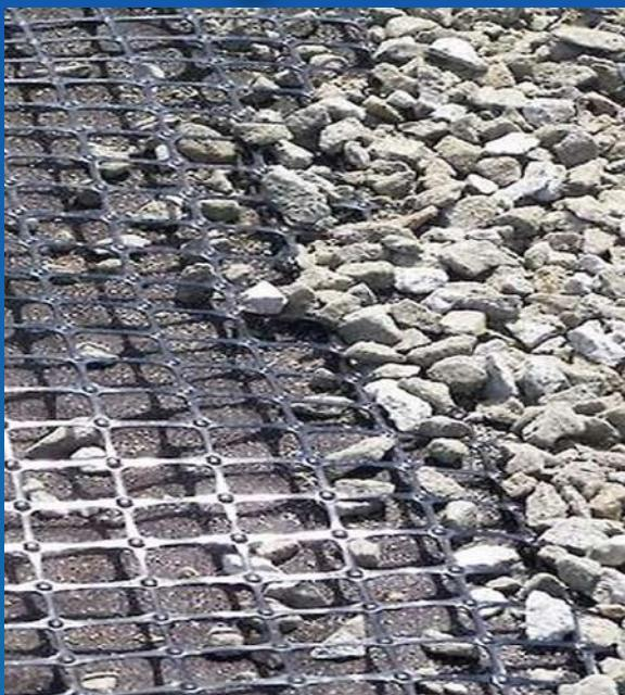
Geogrid Bi-Axial merupakan salah satu dari kategori geosintetik berbahan Polypropylene atau Polyethylene yang di khususkan pada perkuatan. Pembuatan material ini dengan sistem dipanasi lalu diekstrude. Material ini di khususkan mempunyai kekuatan dua arah pada permukaan.
